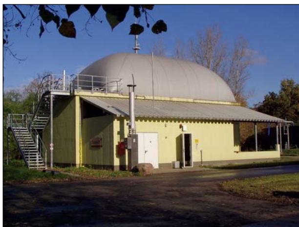
Biogasanlage Groß Kreuz
