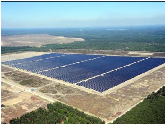
Photovoltaikanlage Lieberoser Heide
