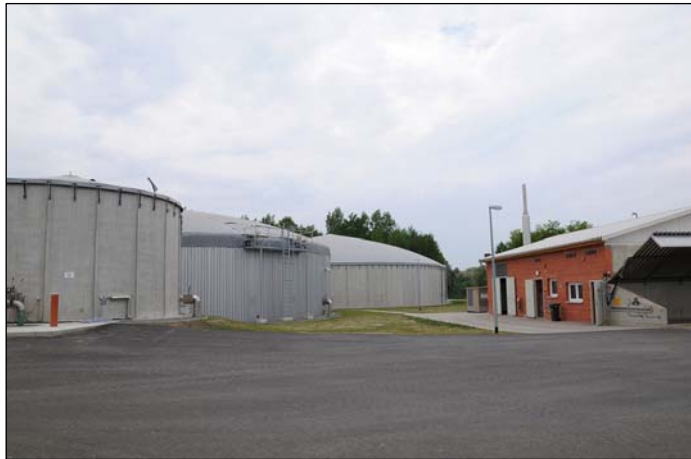
Die Biogasanlage auf dem Gelände des Lausitzrings
