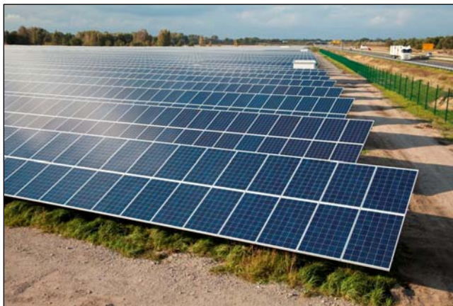
Der neue Solarpark Oranienburg
